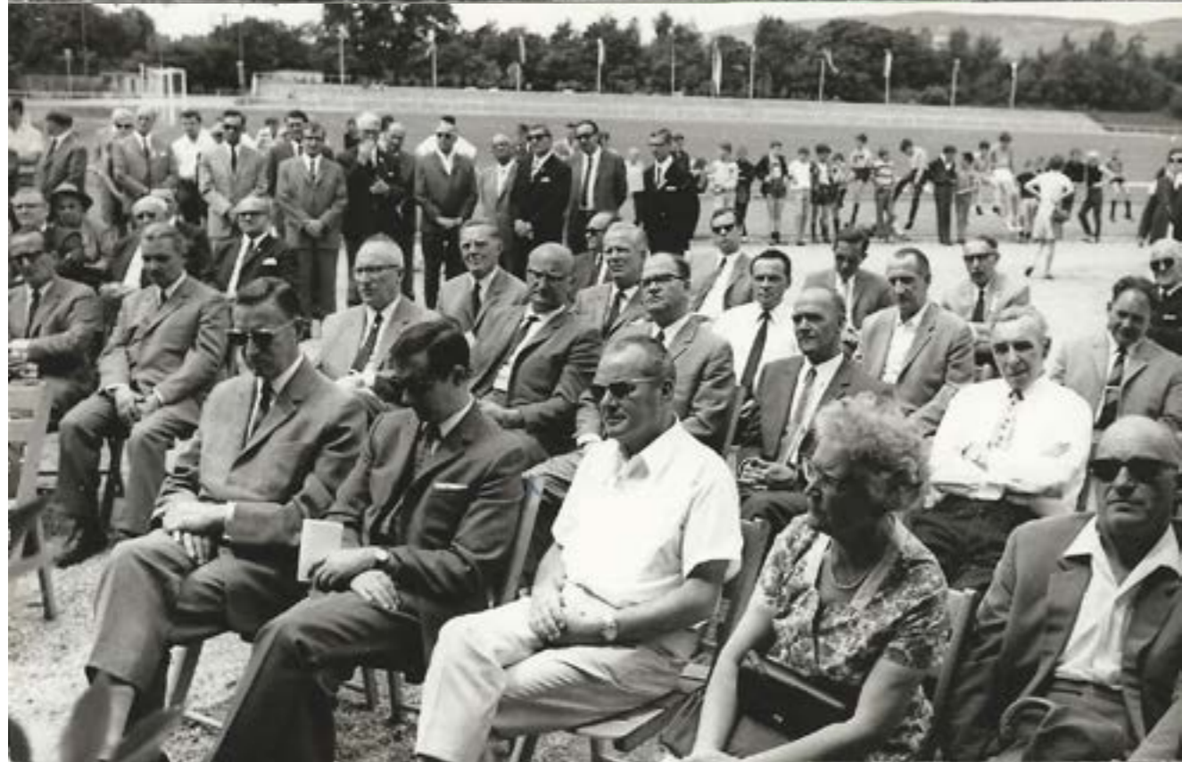
Eröffnungsfeierlichkeiten und Einweihung Stadion Kellersgrube 1968
